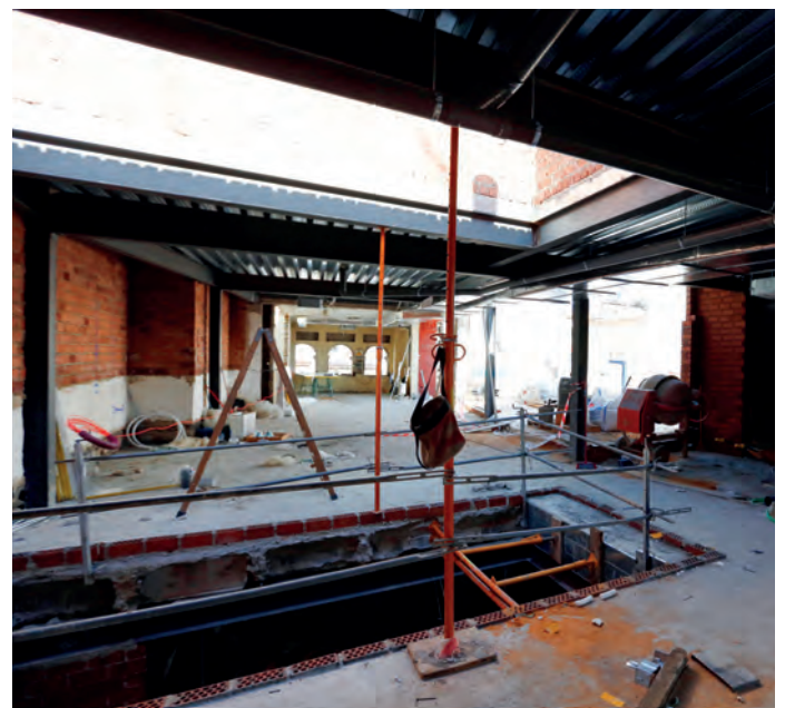
Ampliación y patio interior abierto en la segunda planta.
