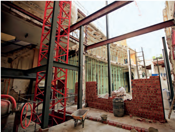
Apuntalamiento de las dos plantas de estructura para la eliminación de pilares.
