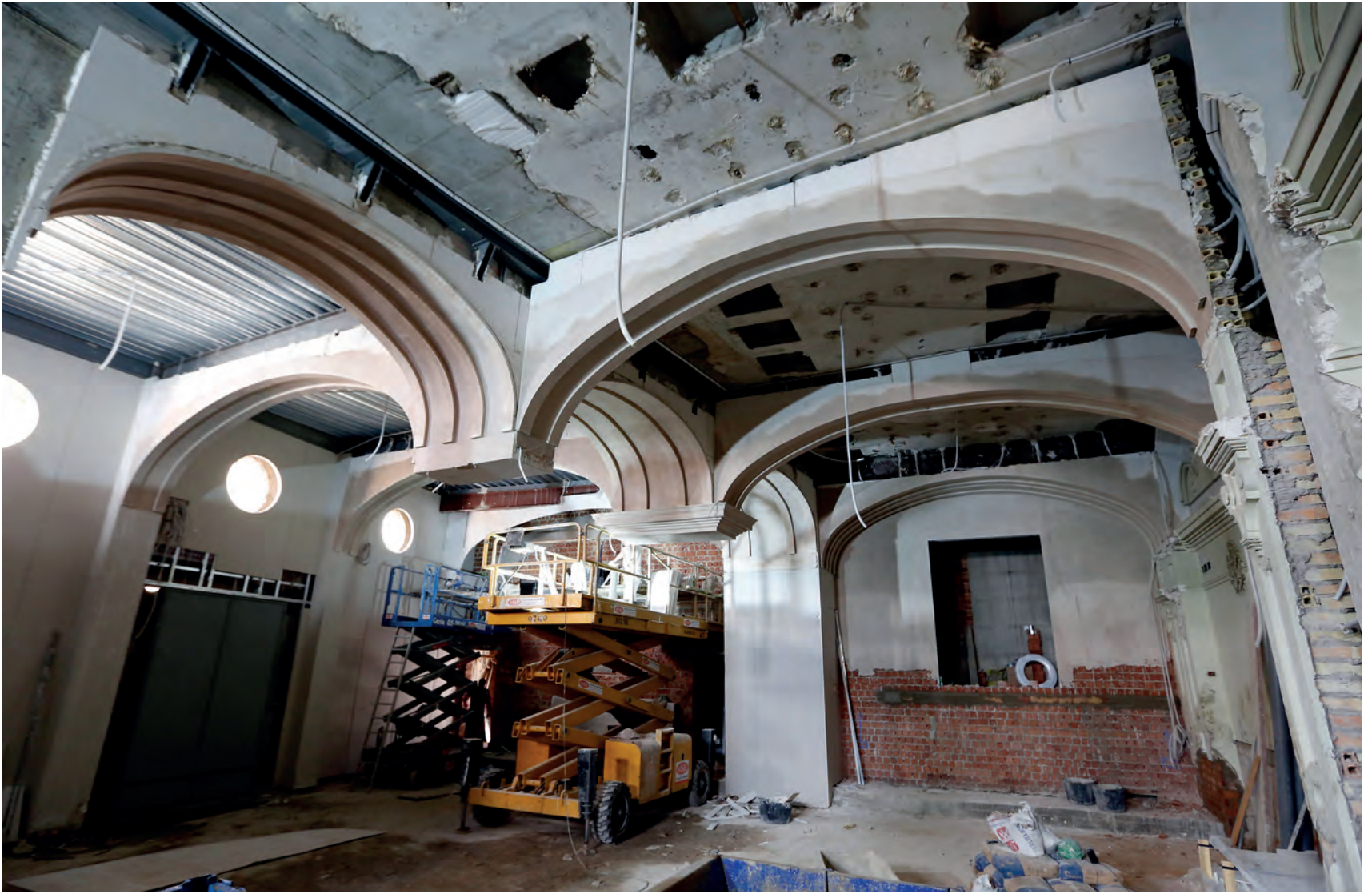
Vista de la Capilla con la nueva puerta de acceso al callejón de Nuestro Padre Jesús de la Penas
