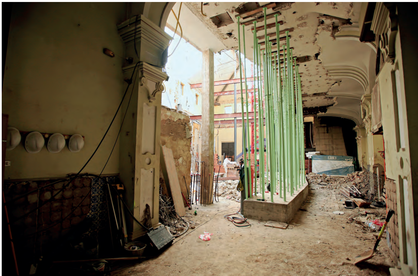
Apuntalamiento de la estructura en la planta baja para la ejecución de la viga principal.
