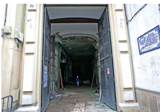
Vista de las obras desde la puerta principal.
