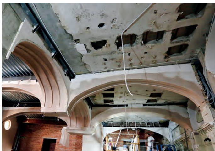
Arcos de las bóvedas de la Capilla.
