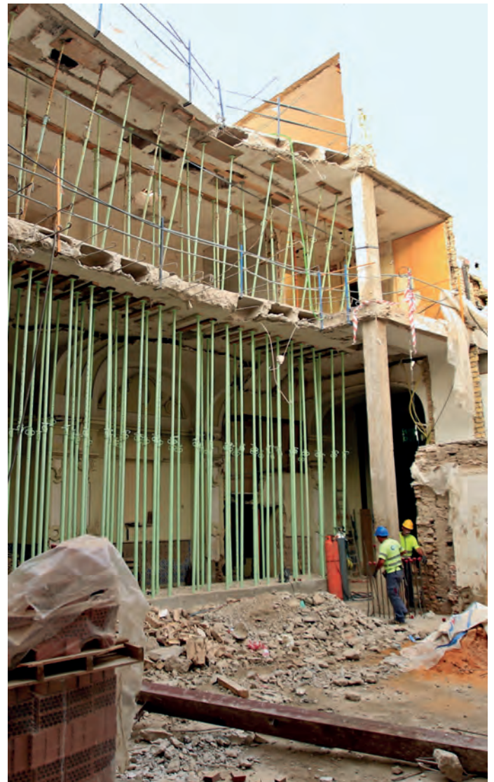
Apuntalamiento de las dos plantas de estructura para la eliminación de pilares.
