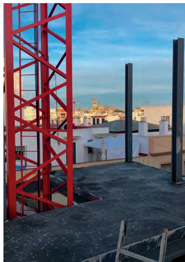
Vista desde la nueva planta de azotea.
