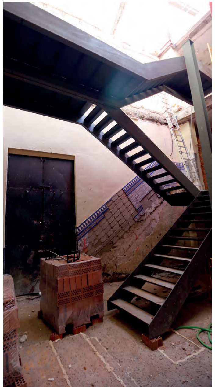
Nueva escalera de la Casa Hermandad.
