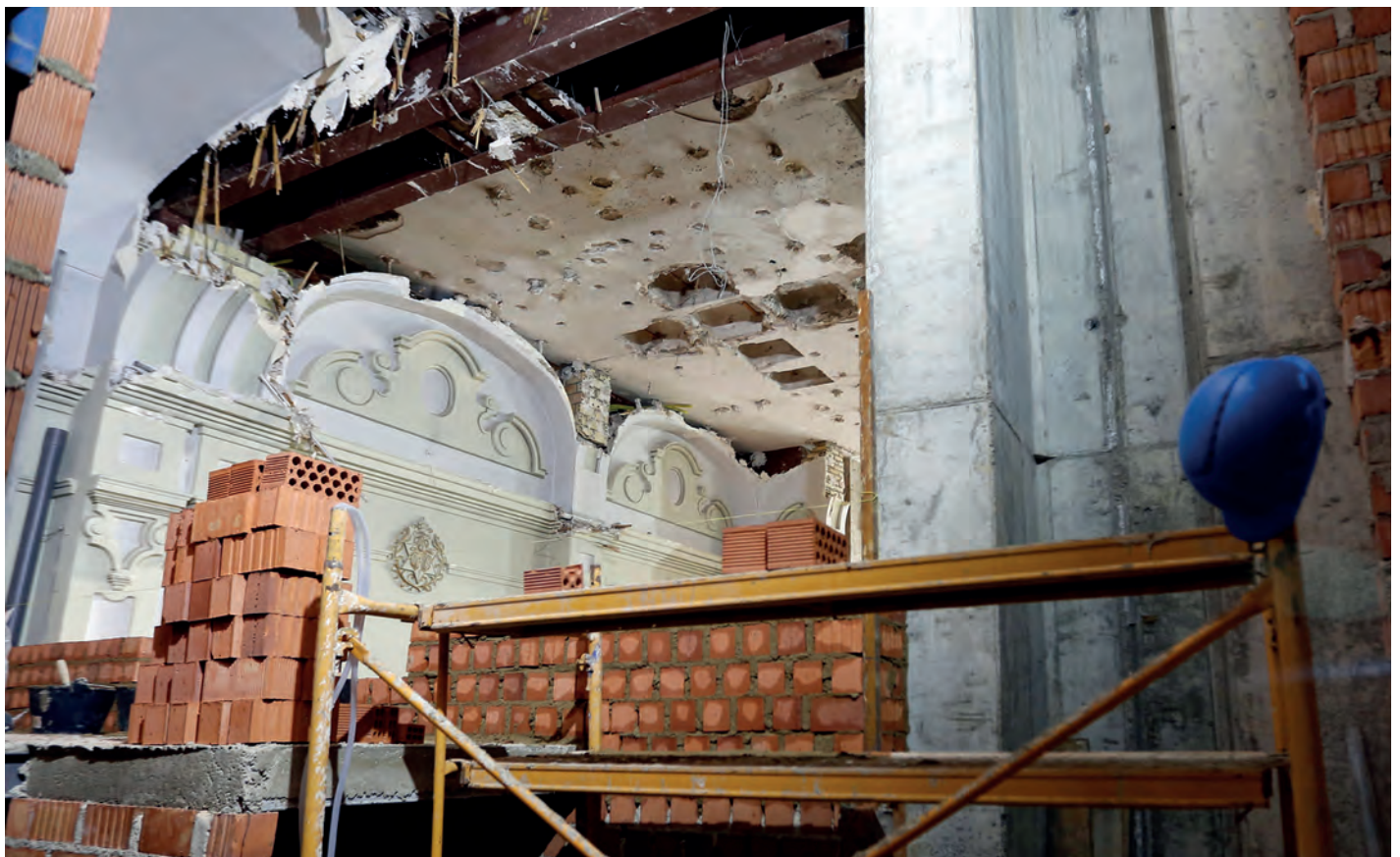
Vista de las obras desde la sacristía y camarín de la Virgen
