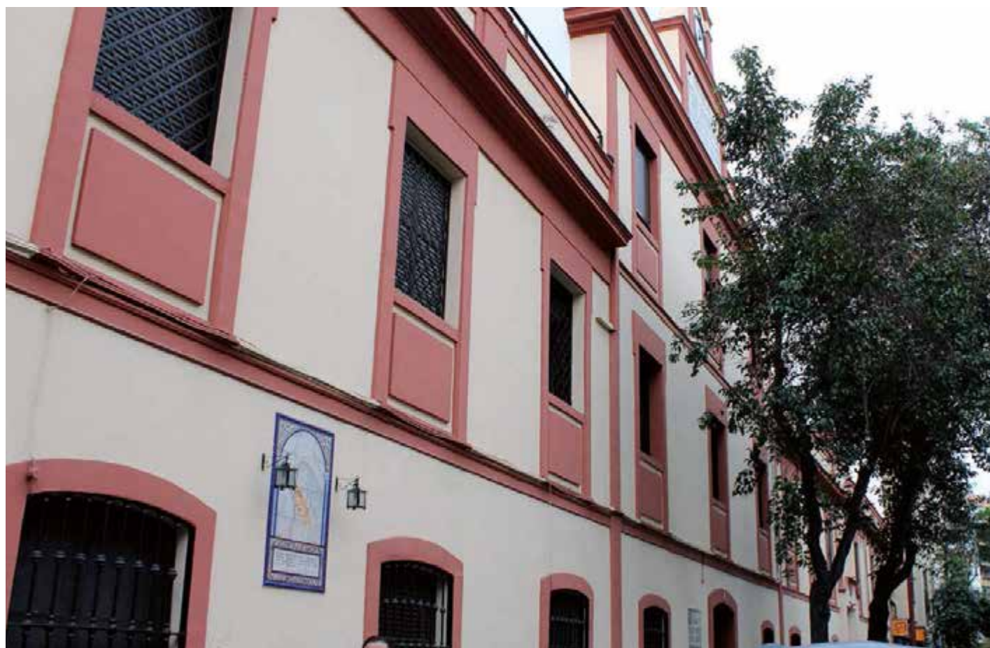
Instalaciones del Economato en la calle Pagés del Corro
