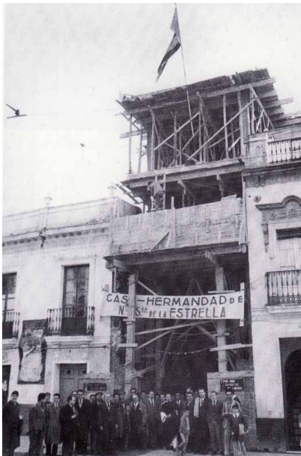
La Casa de Hermandad en construcción
